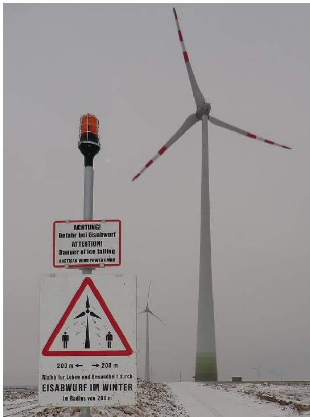
Abb. 1: Möglicher Aufbau einer Eiswarnleuchte mit zusätzlichen Warnschildern
